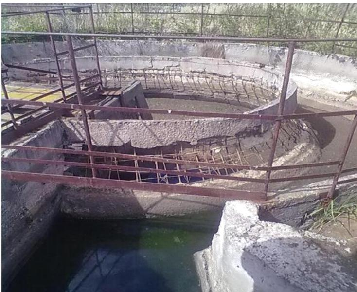
Рис.1 Пример разрушений на песколовке
